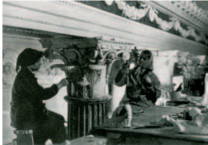
Вверху. Реставрация капителей на колоннах Греческого зала Большого дворца в Павловске. Top. The restoration of the capitals on the columns in the Grecian Hall of the Great Palace at Pavlovsk.
